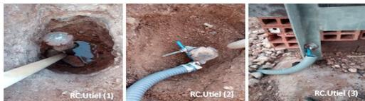
El terreno no resultó blando y la **pica** con la maza, no bajaba más de unos 40 centímetros. Fue necesario utilizar una herramienta mecánica especial (tractor) para hacer la ARQUETA en primer lugar bajando así, 2,37mts de profundidad, con tubo PVC para humedad del fondo, **163€**.
